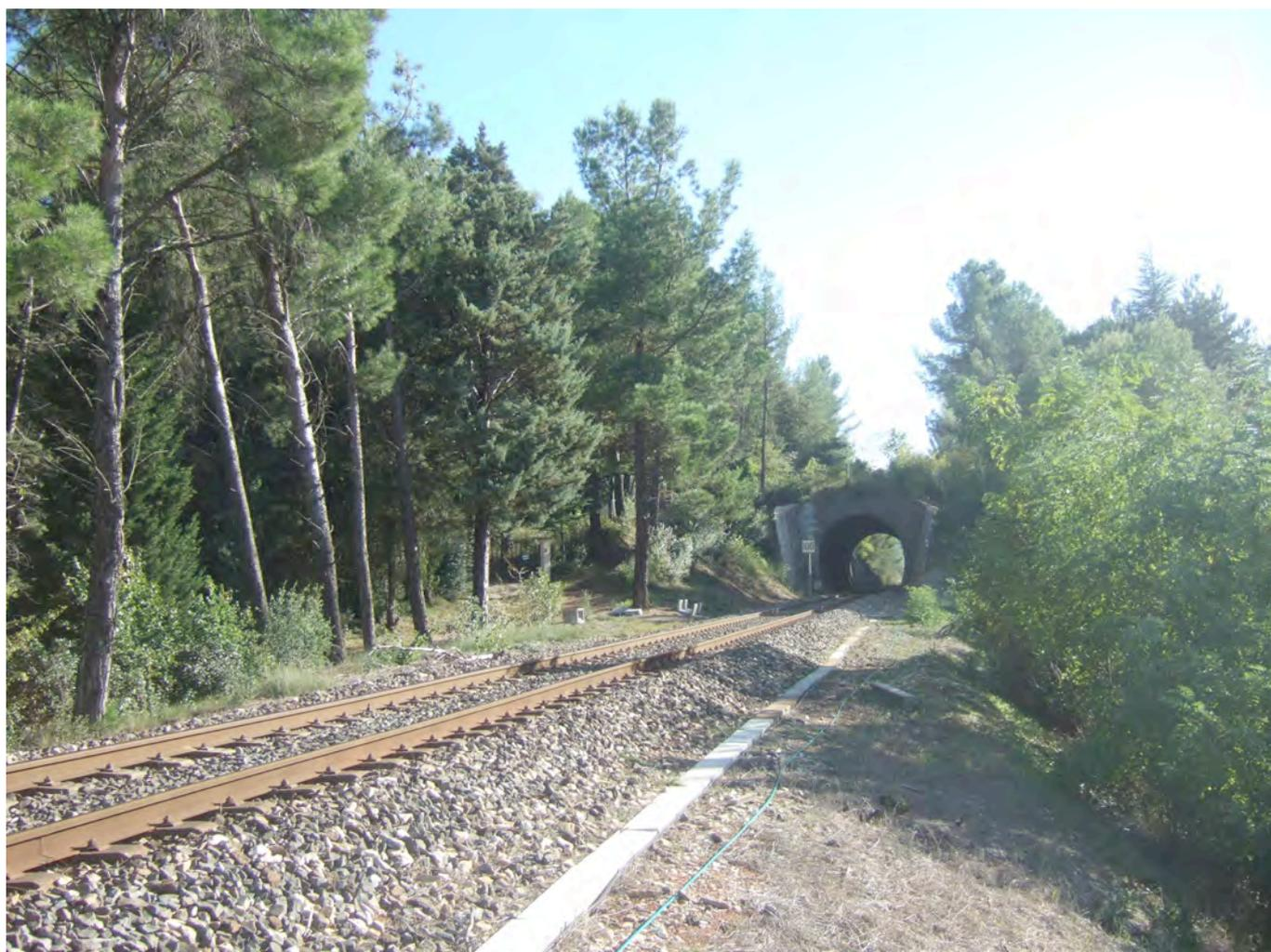
La simple destruction de ce tunnel - sans chercher à élargir les emprises - représenterait un faible volume de déblais (estimé aux alentours de 2000 m3), et il est vraiment dommage de ne pas profiter des 4 mois de fermeture de la ligne exigés par la destruction du Tunnel des 4 Tours, pour opérer également la destruction minimale de ce tunnel.
