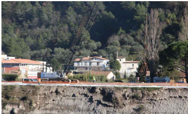
la crue du Var lors de la récente tempête a affouillée la digue juste en aval de la gare de Saint Martin du Var. Les déblais sont retirés pour préparer l'installation d'enrochement. (Photos de Felix Cavallo)
