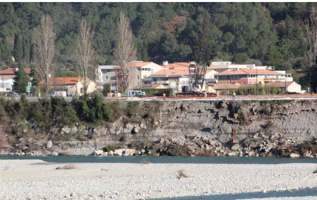
la crue du Var lors de la récente tempête a affouillée la digue juste en aval de la gare de Saint Martin du Var. Les déblais sont retirés pour préparer l'installation d'enrochement. (Photos de Felix Cavallo)
