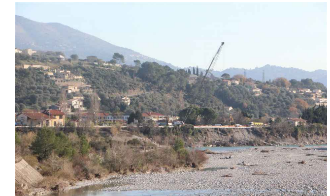
la crue du Var lors de la récente tempête a affouillée la digue juste en aval de la gare de Saint Martin du Var. Les déblais sont retirés pour préparer l'installation d'enrochement. (Photos de Felix Cavallo)
