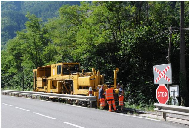
Le mercredi 8 juillet la bourreuse effectue une correction de nivellement en aval de Villars-sur-Var jusqu'au passage à niveau de L'Ablé .
