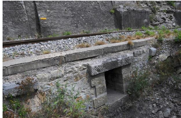
Dans le secteur, le service Voie a mis à profit les mois d'interruption des circulations pour réaliser des travaux d'entretien tels que le débrouillage des abords, le curage des caniveaux et le nettoyage des ouvrages d'art : ici l'aqueduc dallé de 0,60 m au PK 42+275 (ouvrage 228 bis).
