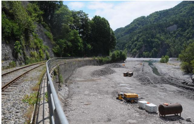
La consolidation des fondations du mur de soutènement (ouvrage 232) va pouvoir s'effectuer pendant l'été sans interrompre la circulation des trains. Le Var a été dévié sur la partie droite de son lit à partir du pont de Sainte-Pétronille.
