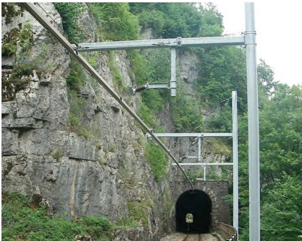
Caténaire rigide Furrer+Frey AG entre 2 petits tunnels de la ligne du Haut-Bugey Bourg - Bellegarde
