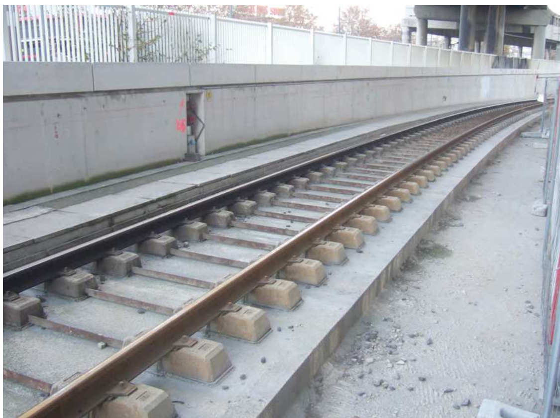
La voie sur dalle béton avec traverses bi-blocs équipées de chaussons élastiques
